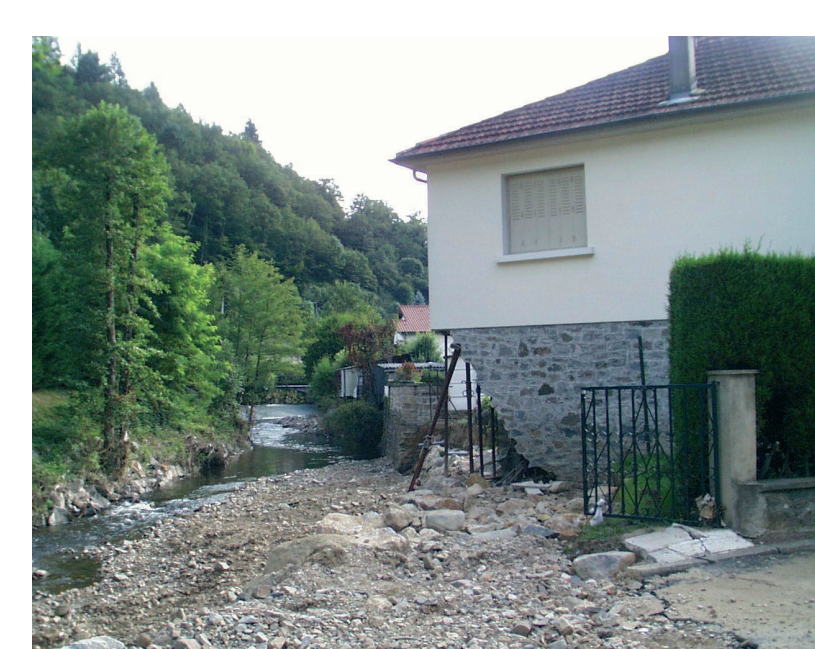
Maison endommagée par la crue de la Saint-Bonnette, juillet 2001
