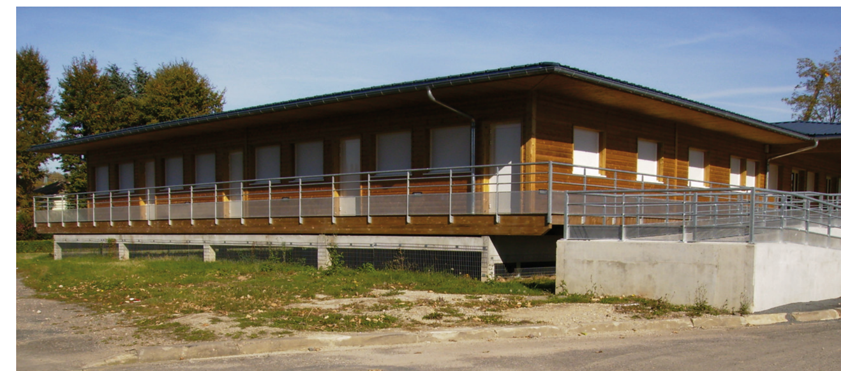
Brive, extension d'un bâtiment sur pilotis.
