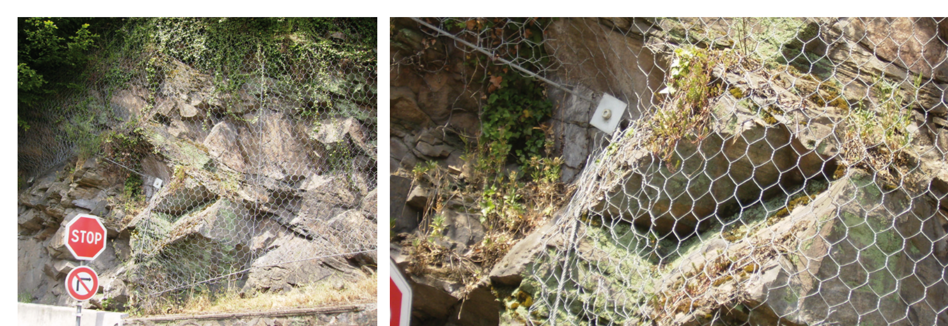
Tulle, nappe de filet métallique posé sur falaise.
