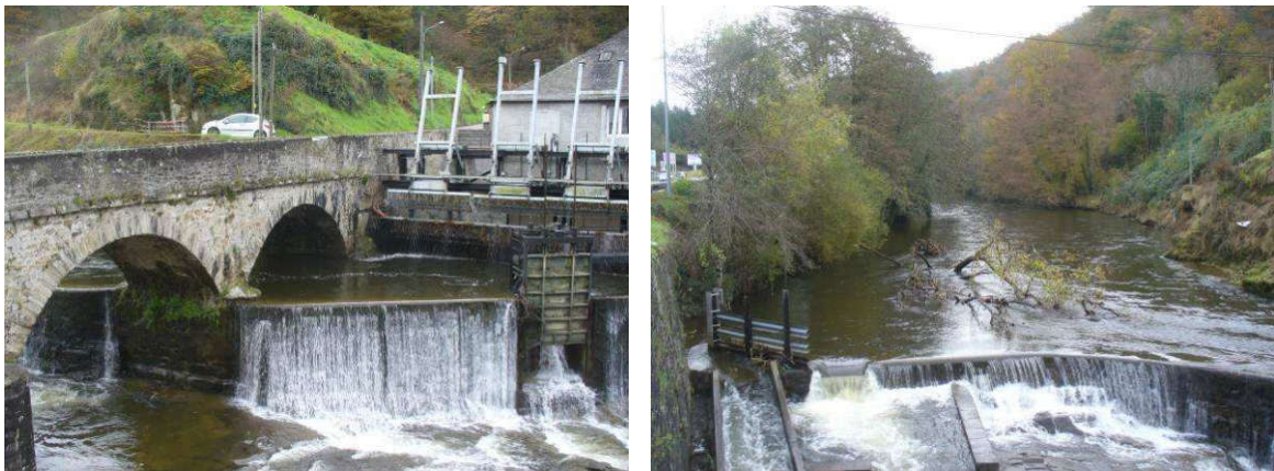
Fig. 6. Seuil et pont du Mulatet sur la Corrèze
