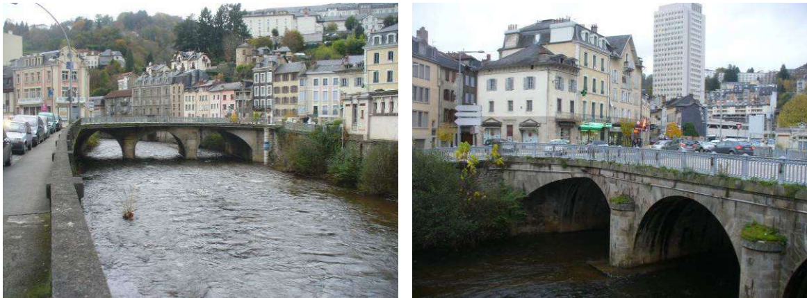
Fig. 5. Pont de la Barrière sur la Corrèze
