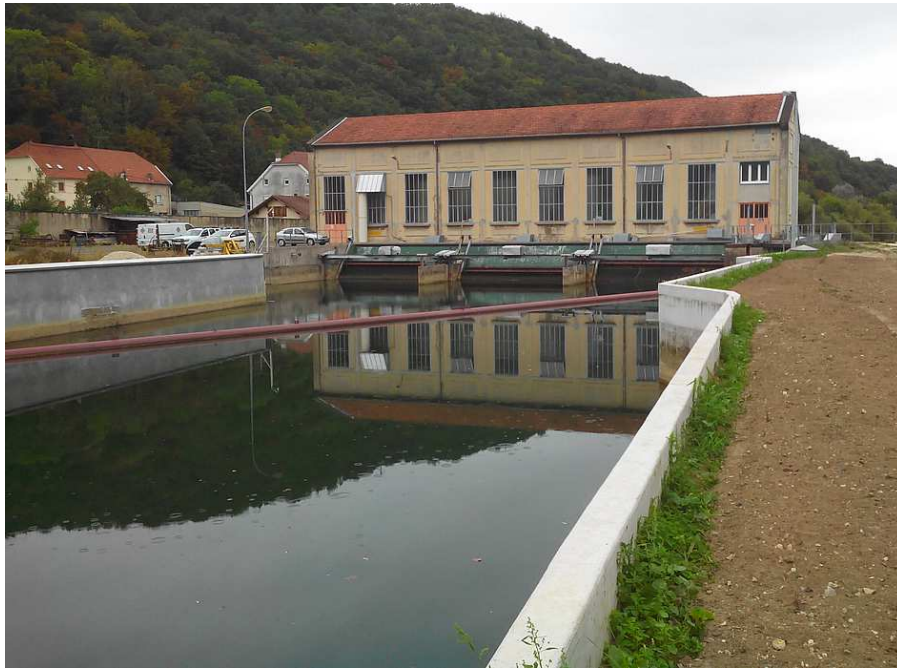
(c) Usine hydroélectrique
