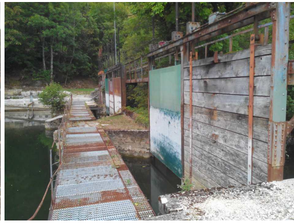
(b) Vannes d'entrée du canal d'amenée
